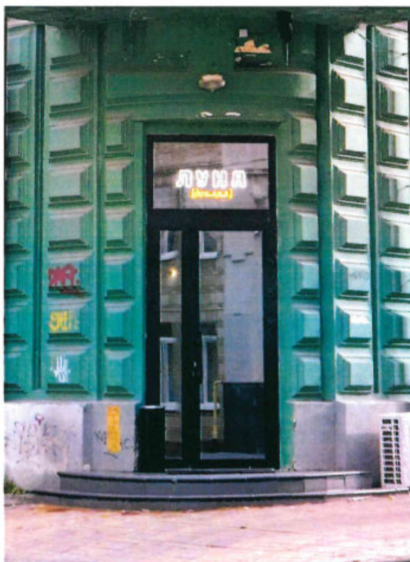
6. Наружная дверь угловой северо-западной раскреповки. Фото 12.2023 г.
