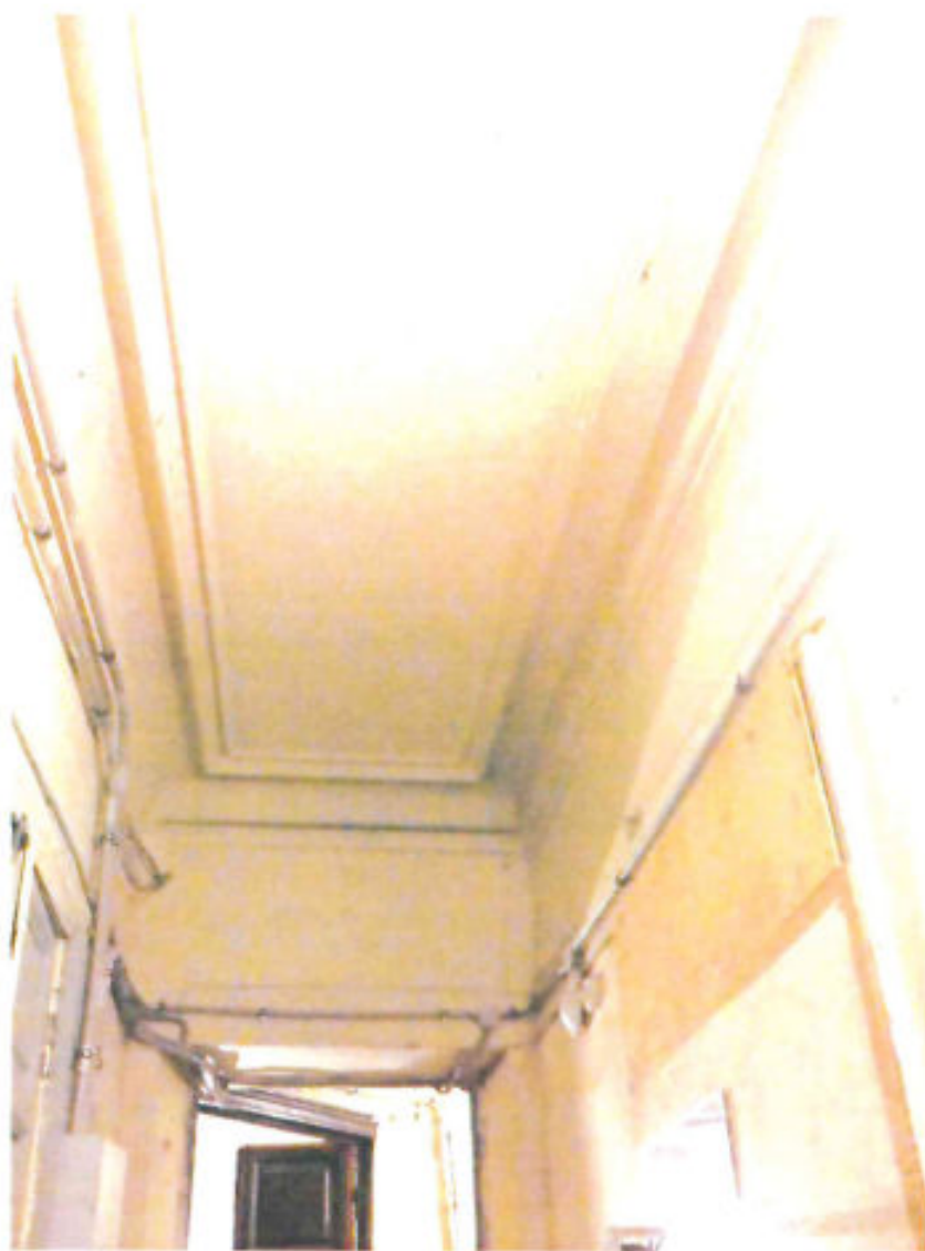
17. Штукатурные тяги потолка в коридоре 2-го этажа. Фото 12.2023 г.
