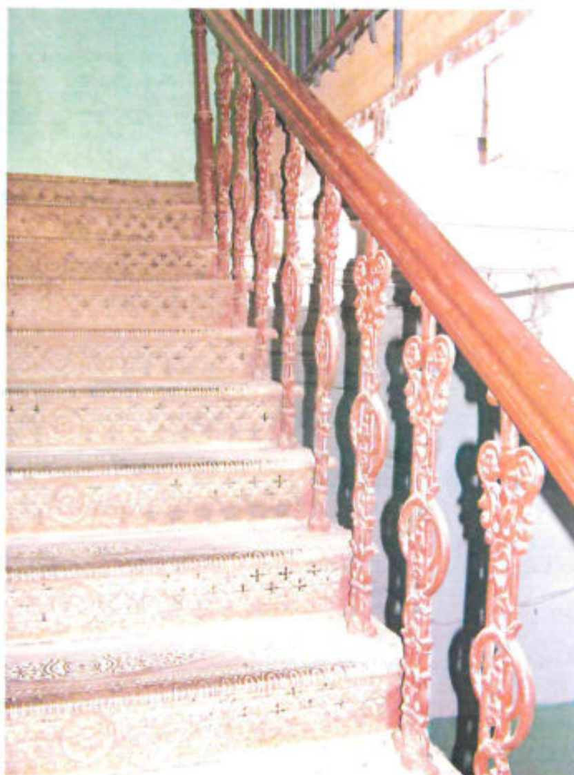
15. Ступени и ограждение внутренней металлической лестницы. Фото 12.2023 г.
