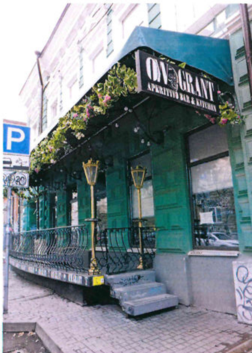
11. Козырек и лестница входного узла северного фасада. Фото 12.2023 г.
