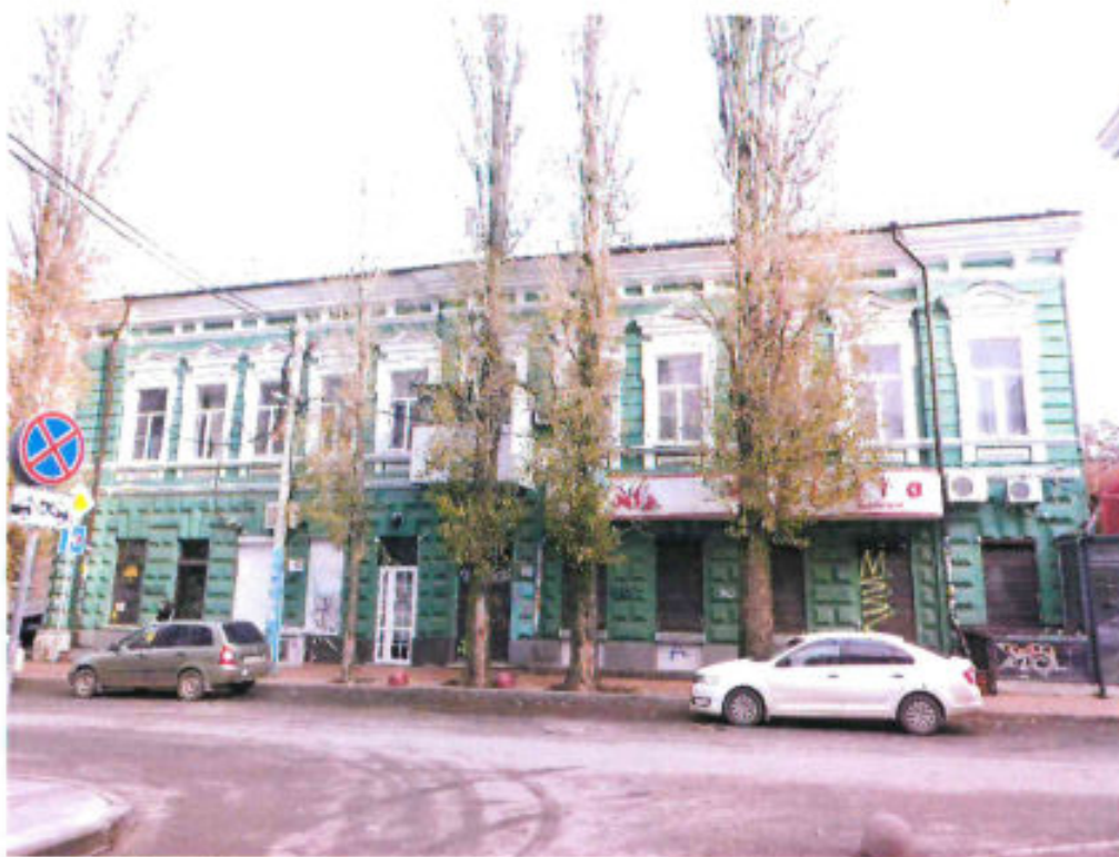
2. Общий вид западного фасада Объекта. Фото 12.2023 г.
