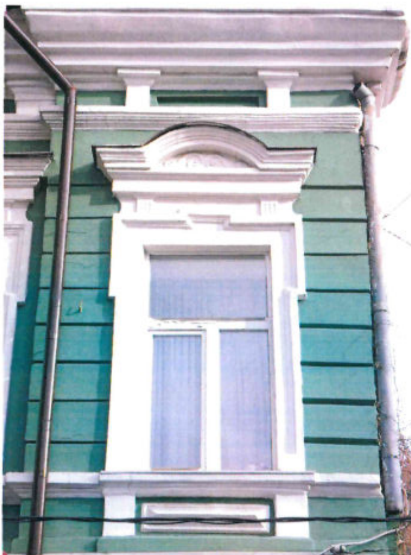
7. Фрагмент раскреповки западного фасада Объекта. Контрналичник окна 2-го этажа. Фото 12.2023 г.
