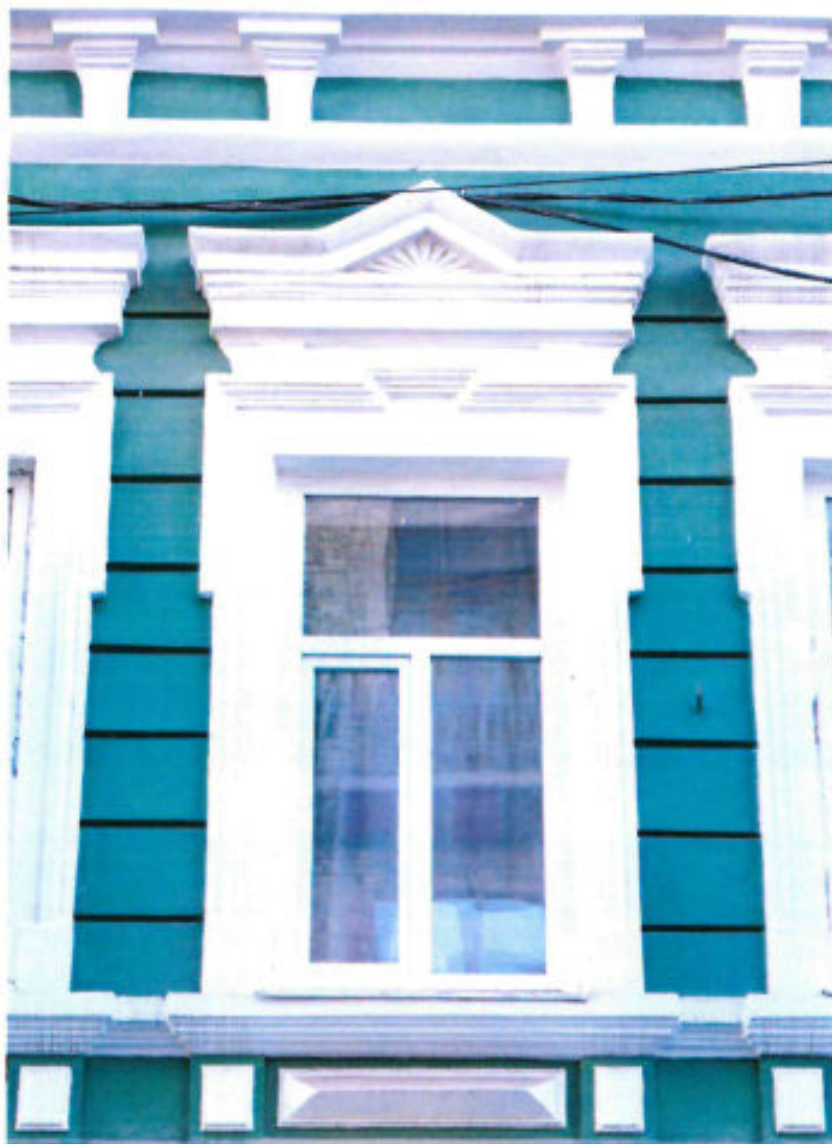
8. Фрагмент западного фасада Объекта. Контрналичник окна 2-го этажа. Фото 12.2023 г.
